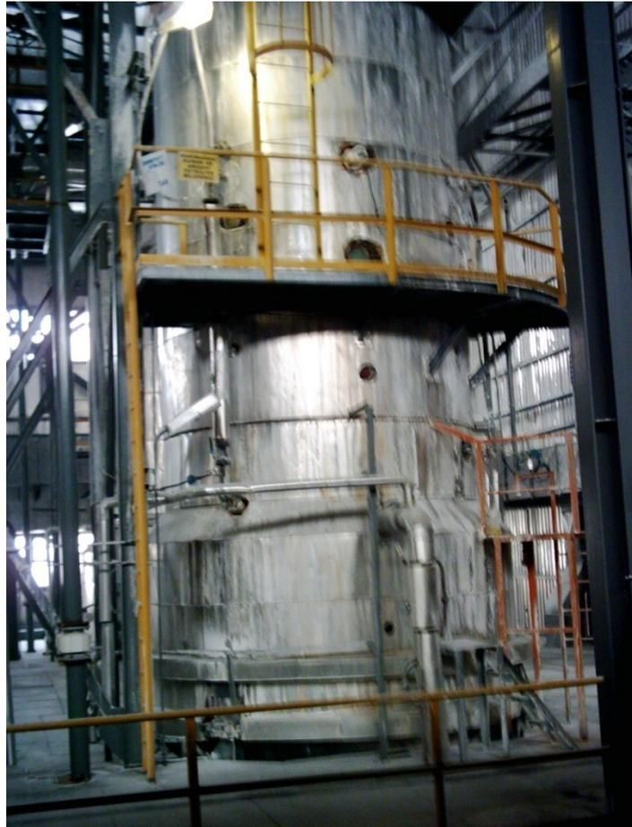
Un nettoyage rigoureux de la surface des cuves fut nécessaire, vu l'adhérence des coulées au support acier. **MetalTec TC** ne nécessitant pas de sablage, une surface dégraissée, propre et sèche fut suffisante comme préparation à l'application du produit.
