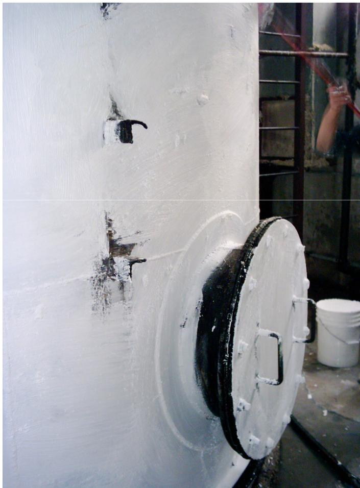
**MetalTec TC** a pu être appliqué en couches de 0.5 mm, afin d'assurer une parfaite adhérence et une isolation optimale. Comme sa température maximale d'application est de 200°C, la cuve n'a dû être immobilisée que quelques heures (temps du séchage).
