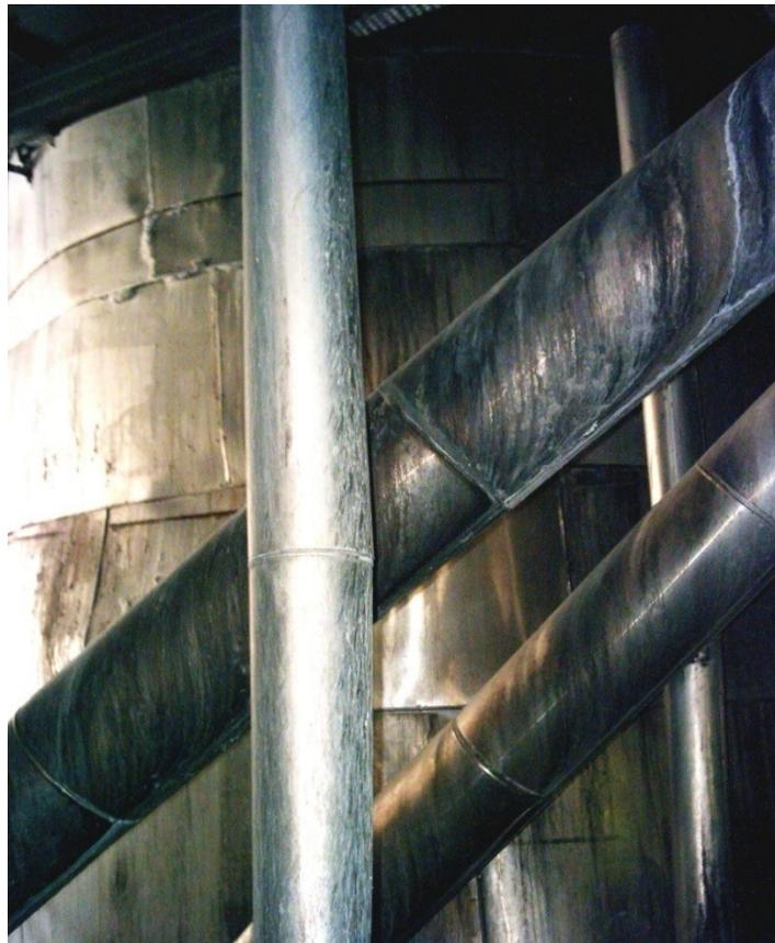
Après une série de tests avec **MetalTec TC**, réalisés dans des situations extrêmes et sur plusieurs années, le département maintenance d'Etibor décida en mai 2005 d'enlever l'ancienne isolation d'un crystalizer et de le revêtir du **TC**-remarquable produit d'isolation thermique liquide chargé de microsphères de céramique et de verre- afin de garantir une parfaite étanchéité, doublée d'une inspectabilité de tous les instants.
