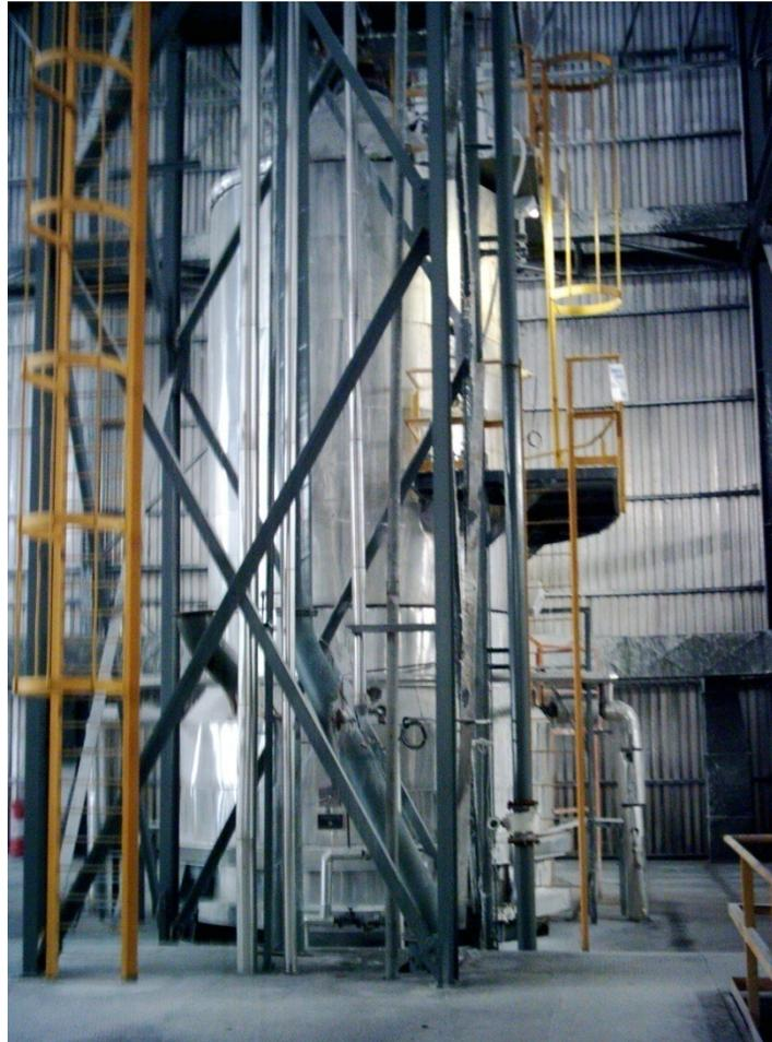
Ces crystalizers sont traditionnellement isolés avec de la laine de roche ou de la mousse PU mais l'humidité abîme rapidement ces types d'isolation et provoquent des coulées (visibles sur ces photos). Celles-ci pénètrent les coques alu et détruisent la laine de roche qui n'isole plus du tout en ambiance humide.
